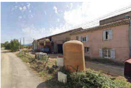
Figure 84 : Bâti rural dispersé, photo : Atelier Sol et cité.
