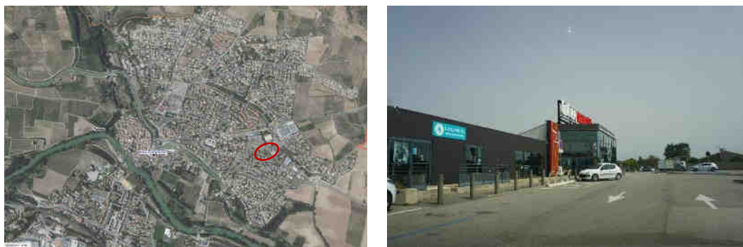
Figure 118 : Intermarché - Bricomarché, photos : Sol et cité.
