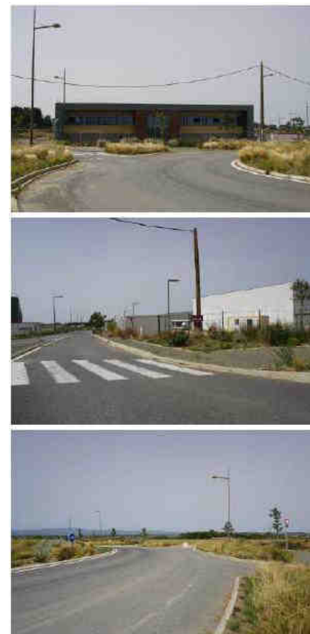
Figure 51 : Photographie du parc d'activités de Béragne, photos : Sol et cité.
