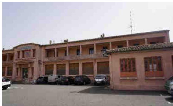
Figure 134 : Ecole en cours de réhabilitation, photo : Sol et cité.
