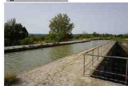
Pont aqueduc sur l'Orbiel
