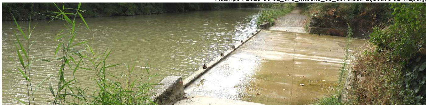
Acampo : 2020-08-02_079_marche_09_déversoir aqueduc du Trapel.jpg
