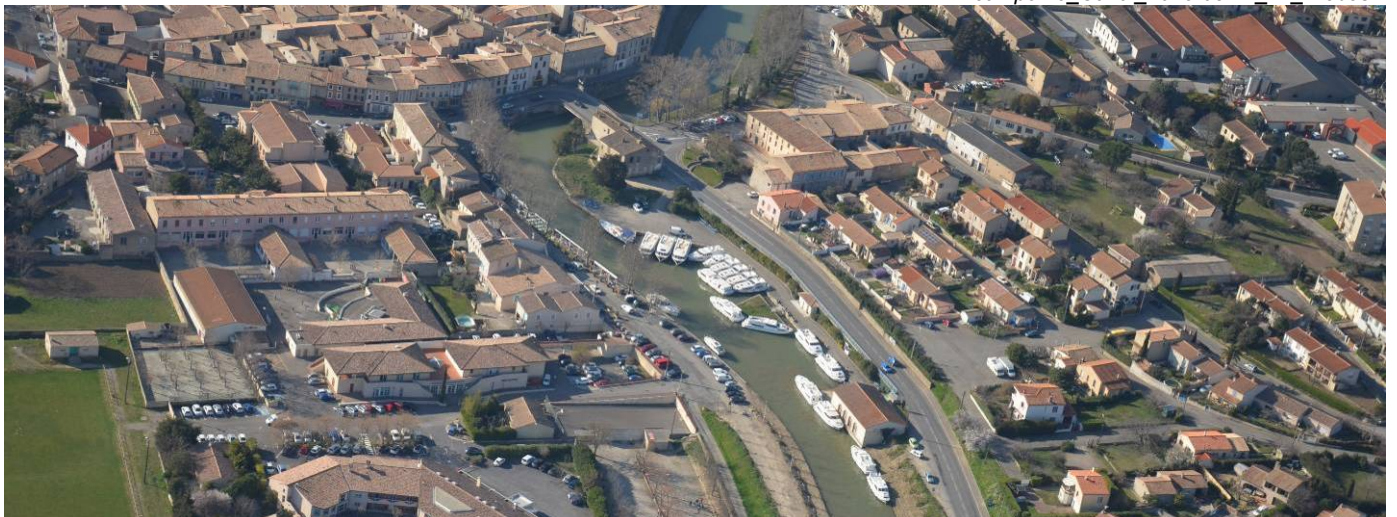
Acampo : 9 Canal_2015-03-12_21 Trèbes
